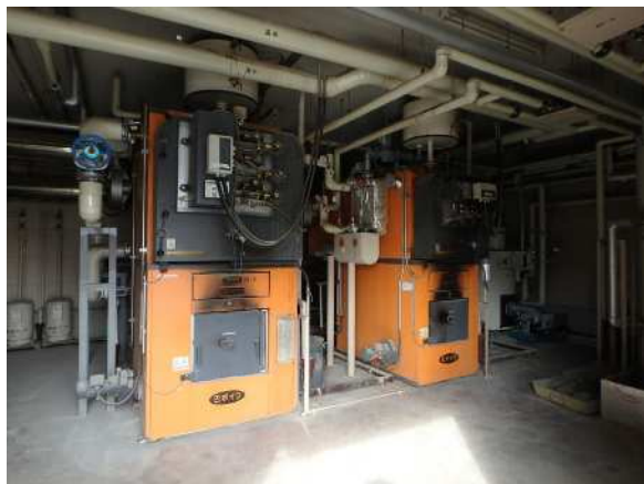
【木質チップボイラー】
