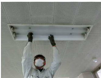
① 蛍光管をはずす。
