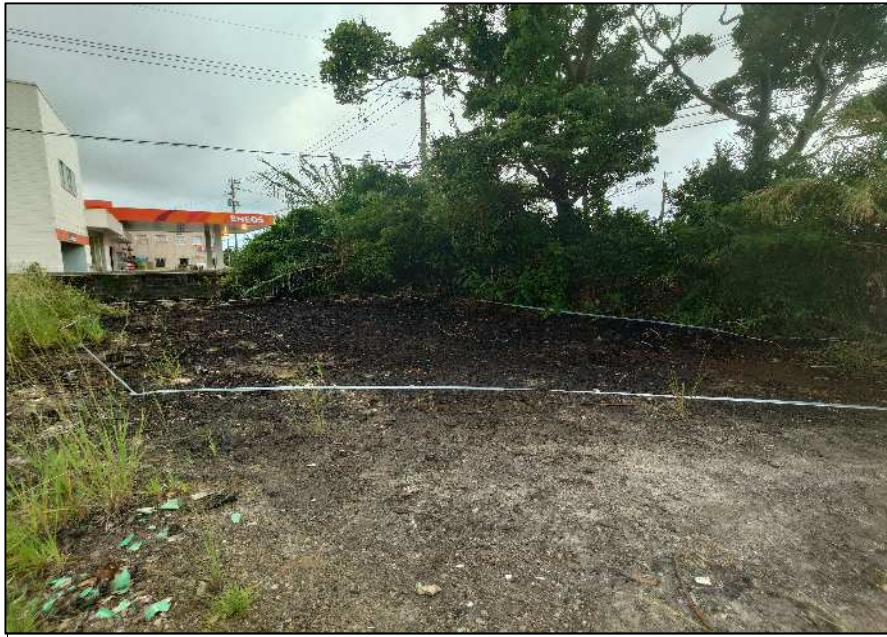
廃土撤去現場 1 カ所目
