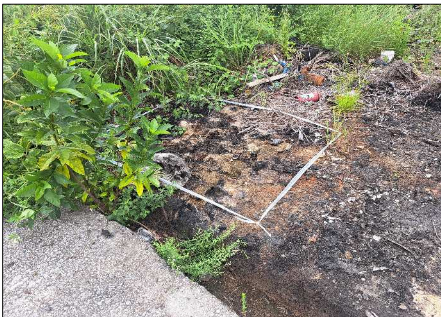
廃土撤去現場 2 カ所目
