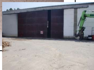
建屋(チップヤード)の外観
