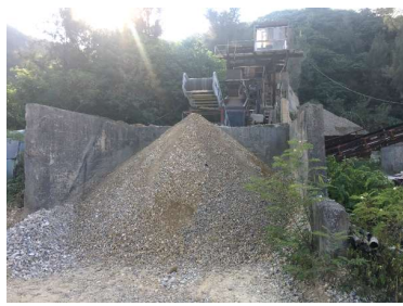
RC-40 (コンクリート)
