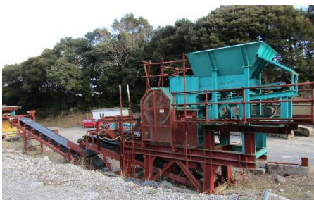
⑤ 小割して1次破碎機に投入 (株)アステクニカ製36-25キープジョー
