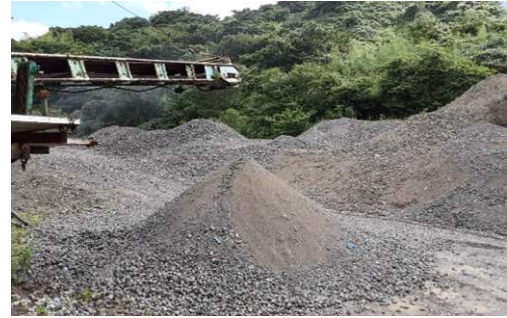
⑮ 2次破碎後の製品出口
