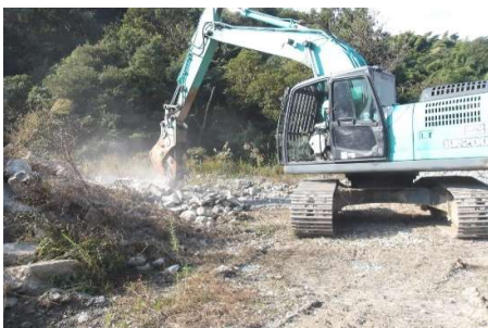
④ 小割状況 磁選機で金属等の除去
