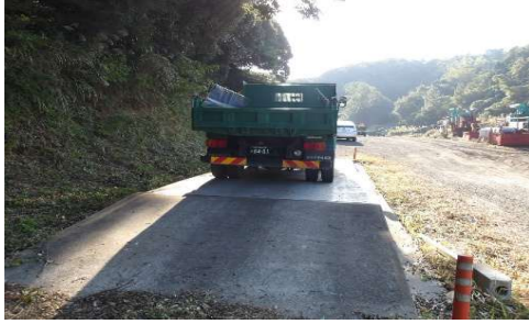
① がれき類搬入、トラックスケールで計量 マニフェスト受付
