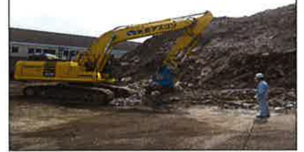
粉塵対策①（散水）
