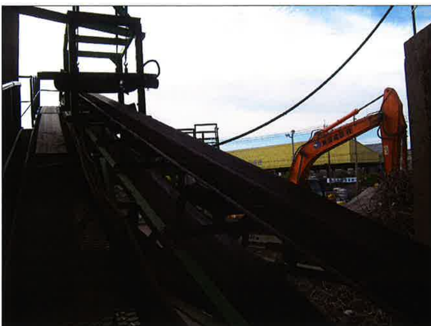
路盤材ベルコン
