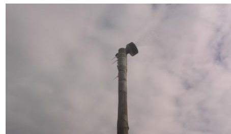
防塵対策として散水を行っている。○で囲っている部分
