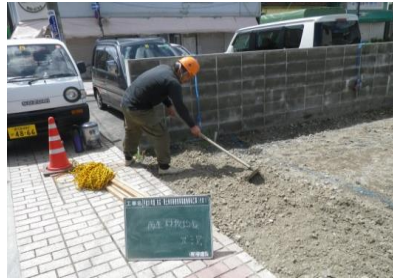
現場施工(埋戻状況)
