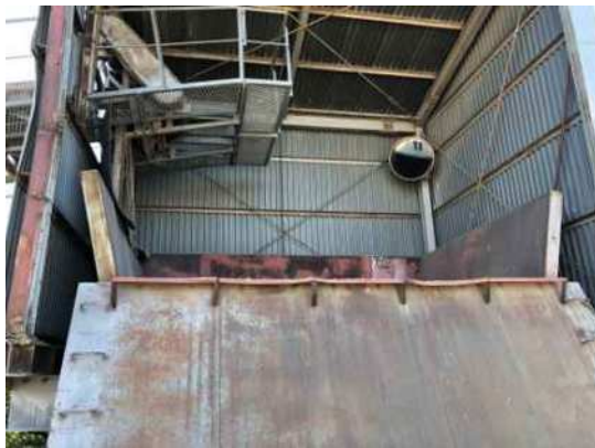
破碎プラントへの 投入口
