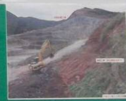
工事施工写真
