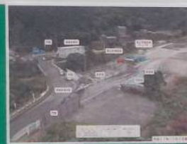
工事施工写真
