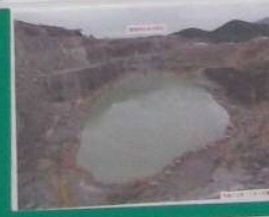
工事施工写真
