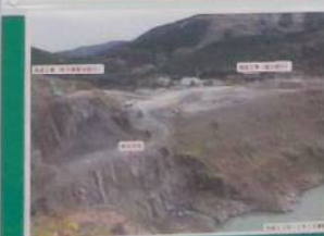
工事施工写真
