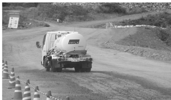
場内散水(粉塵防止対策)
