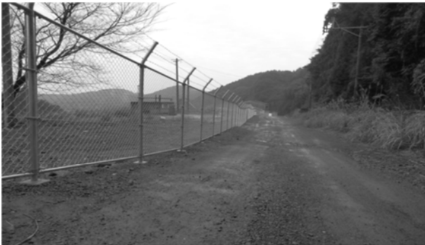
囲障工(東側フェンス)
