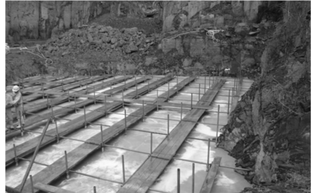
埋立地底部・充填コンクリート打設終了
