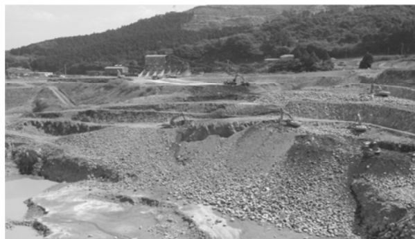
埋立地造成工事(硬岩掘削)
