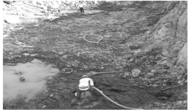
埋立地底部・岩盤清掃
