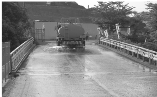
公道散水(粉塵防止対策)
