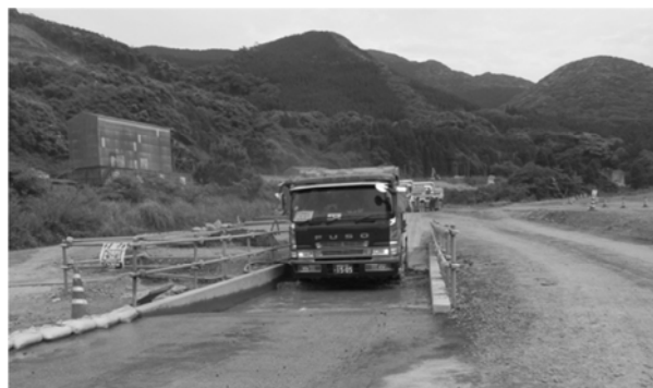
タイヤ洗浄中(タイヤ洗浄プール)
