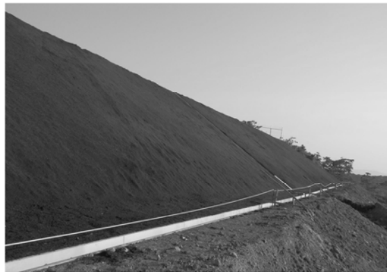
防災調整池法面吹き付け工
