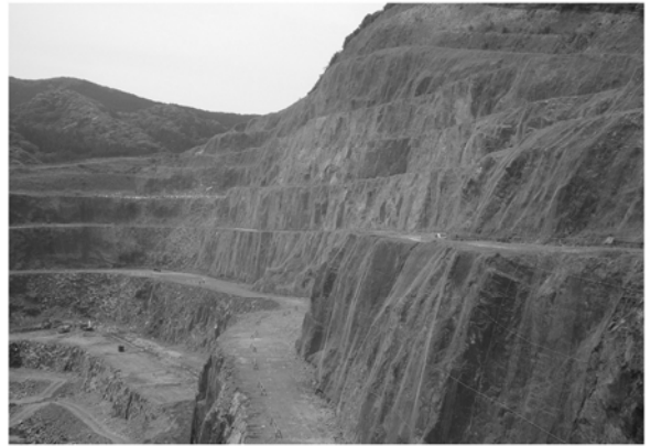
落石防護網工(概ね完成)
