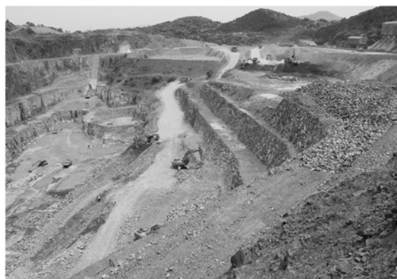
埋立地造成工事(硬岩掘削)
