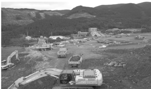
防災調整池部分造成工事 (掘削・積込・土砂運搬)
