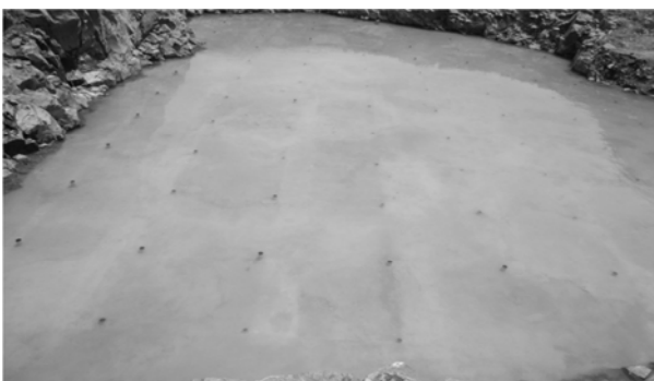
充填コンクリート湿潤養生
