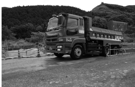
タイヤ洗浄中(タイヤ洗浄プール)
