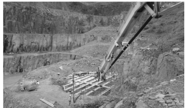
埋立地底部・充填コンクリート打設
