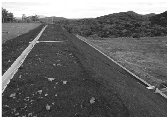
防災調整池法面吹き付け工
