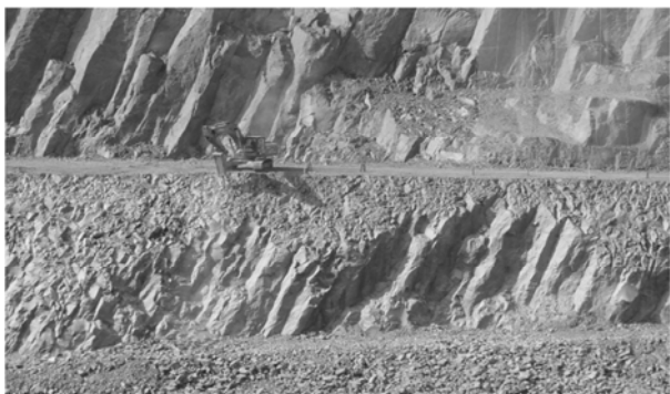
埋立地造成工事(硬岩掘削)
