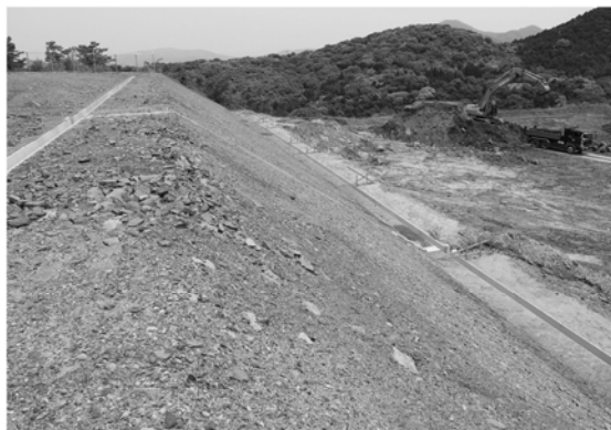
防災調整池小段排水工設置
