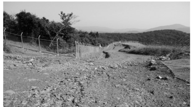
囲障工(西側フェンス)
