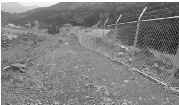
囲障工(南側フェンス)
