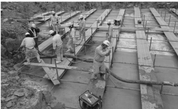
埋立地底部・充填コンクリート打設
