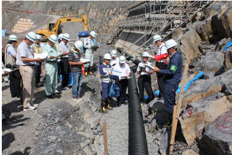
地下水集排水施設
