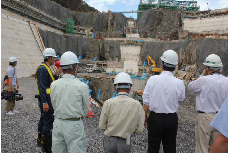
貯留構造物（コンクリート式擁壁）
