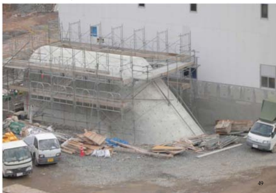
点検用通路・完成(西側)
