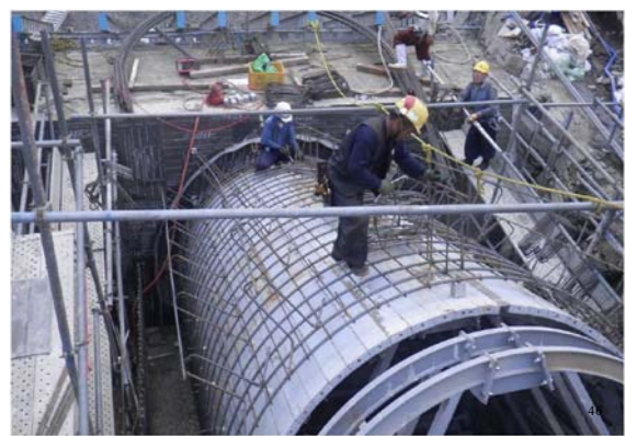
点検用通路・鉄筋組み立て
