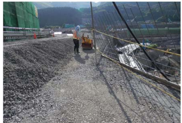
貯留構造物(コンクリート式擁壁)
