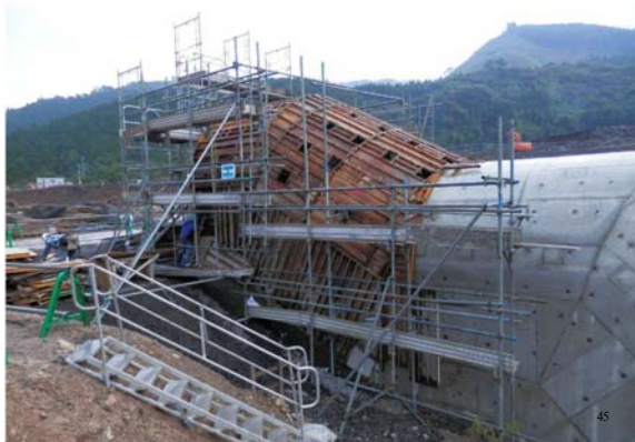
点検用通路・型枠設置
