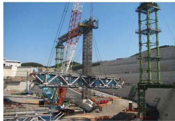
覆蓋施設・キールトラス架設
