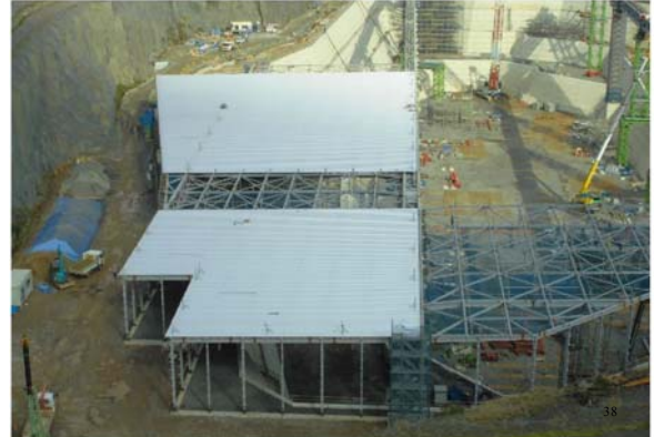
覆蓋施設・屋根据え付け
