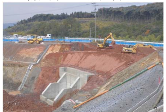
防災調整池・放流塔完成
