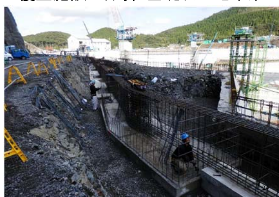
覆蓋施設・外周柱基礎及び地中梁
