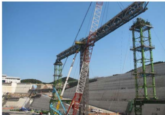
覆蓋施設・キールトラス架設
