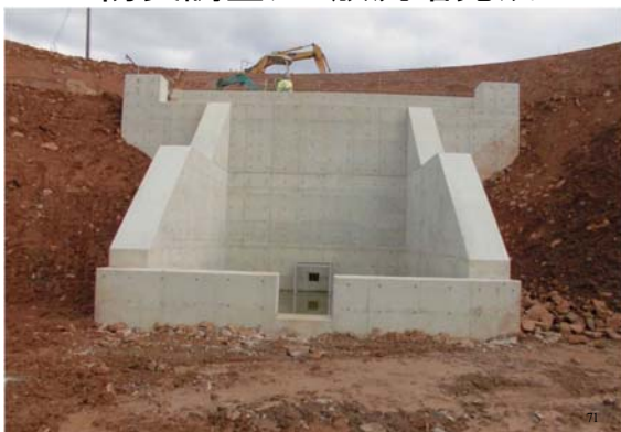
防災調整池・放流塔完成
