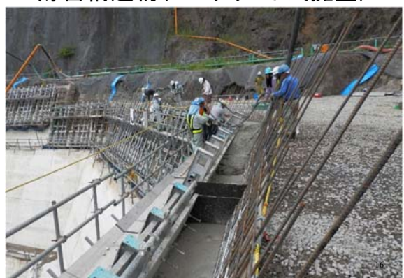
貯留構造物(コンクリート式擁壁)
