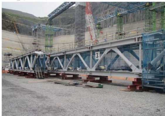
覆蓋施設・キールトラス地組完了
