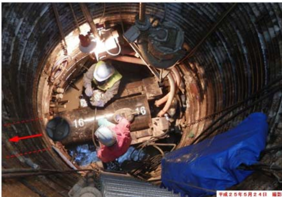
地下水放流管・掘削中
