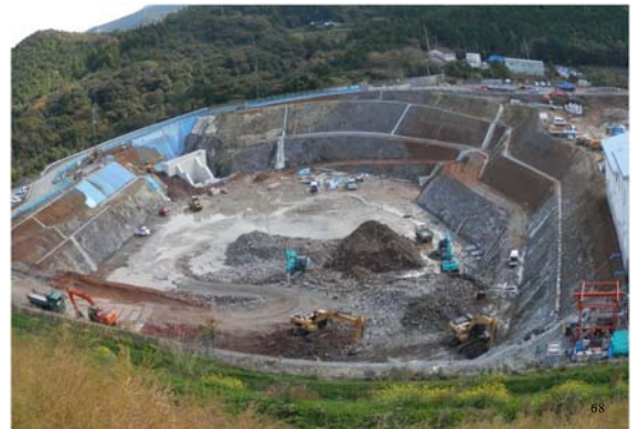
防災調整池・造成工事
