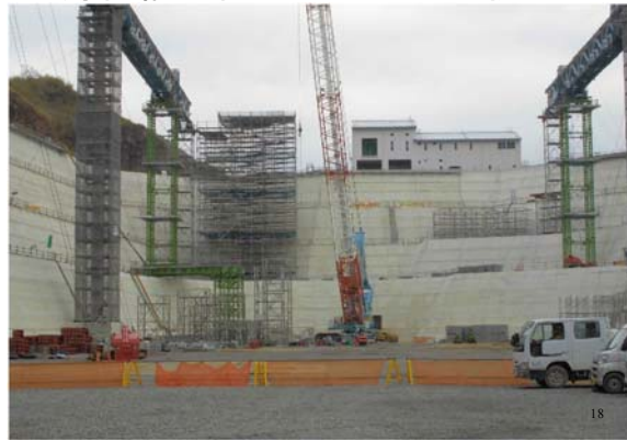
貯留構造物(コンクリート式擁壁)
