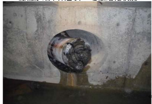
地下水放流管 人孔№1から地下水ピットへ向けて掘削した 機械が地下水ピットへ到達した状況
