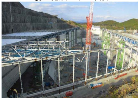
覆蓋施設・トラス架設
