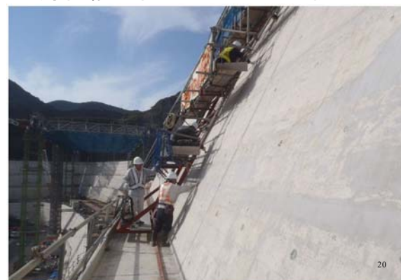
貯留構造物(コンクリート式擁壁)
