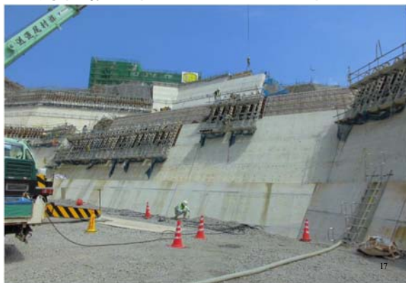
貯留構造物(コンクリート式擁壁)
