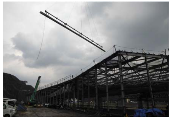
覆蓋施設・屋根据え付け
