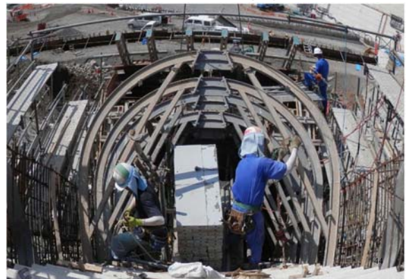
点検用通路・型枠設置
