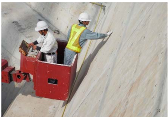
貯留構造物(コンクリート式擁壁)
