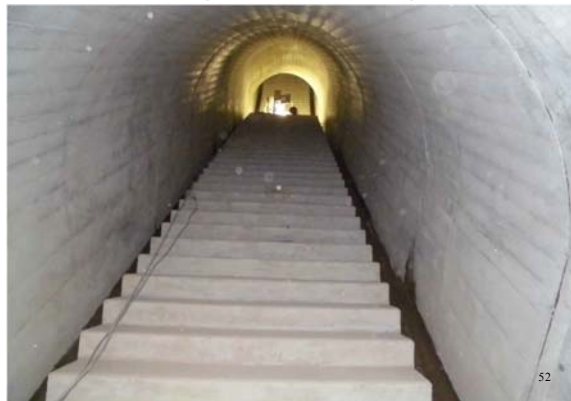
点検用通路・内部
