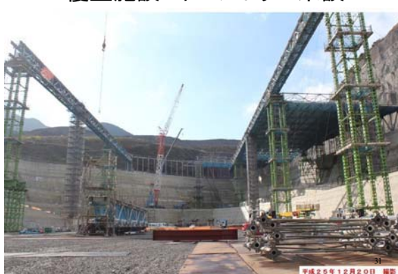
覆蓋施設・キールトラス架設
