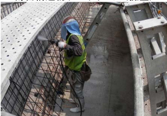
貯留構造物(コンクリート式擁壁)
