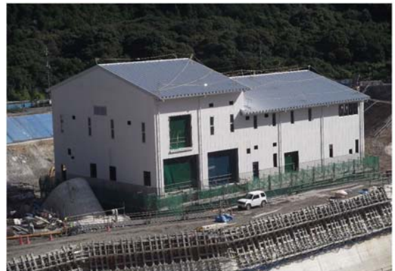
浸出水処理棟
