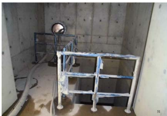
点検用通路・浸出水ピット
