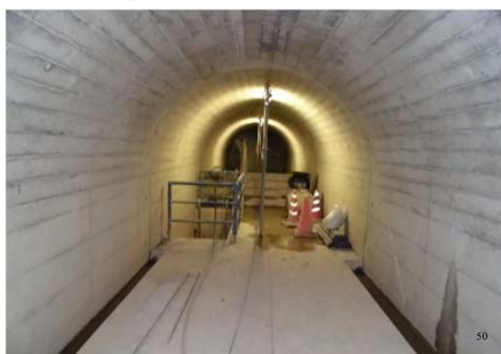
点検用通路・地下水ピット
