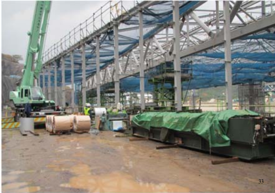
覆蓋施設・折板屋根製作
