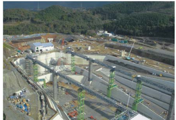
貯留構造物(コンクリート式擁壁)
