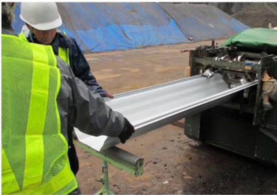
覆蓋施設・折板屋根整形完了
