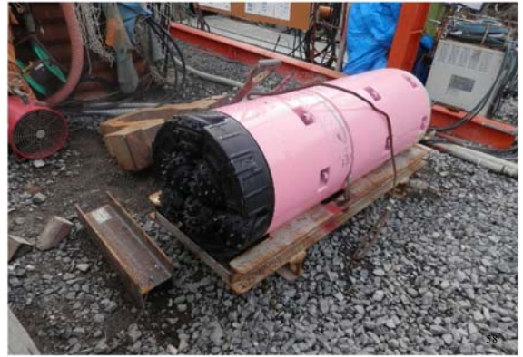
地下水放流管・掘削機械
