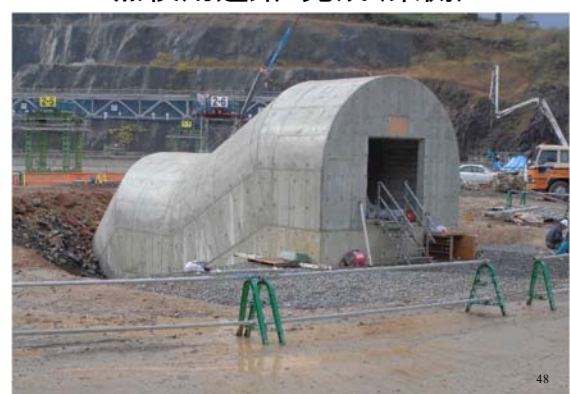
点検用通路・完成(東側)
