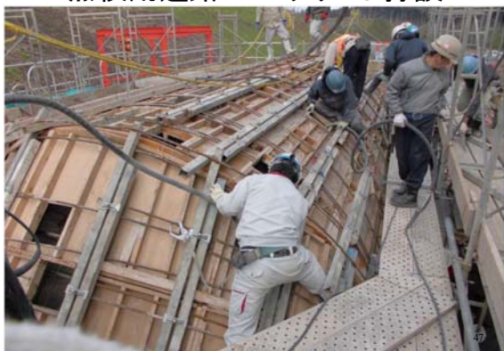
点検用通路・コンクリート打設
