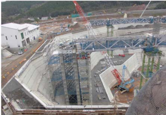
貯留構造物(コンクリート式擁壁)
