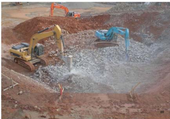
防災調整池・造成工事
