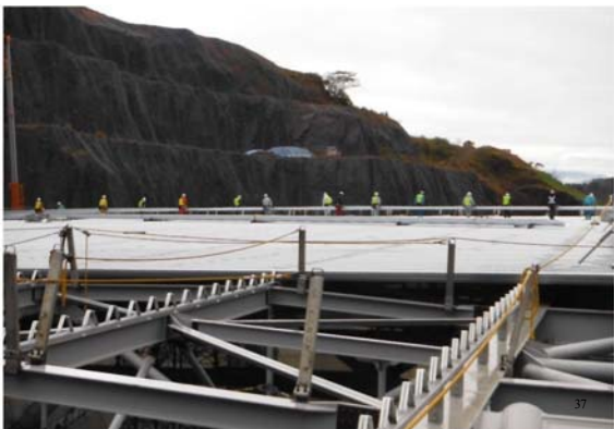
覆蓋施設・屋根据え付け
