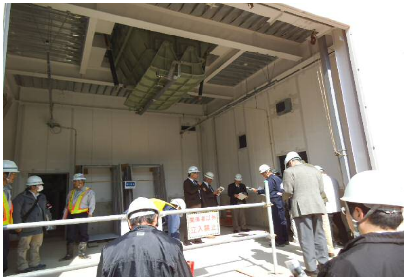
浸出水処理施設
