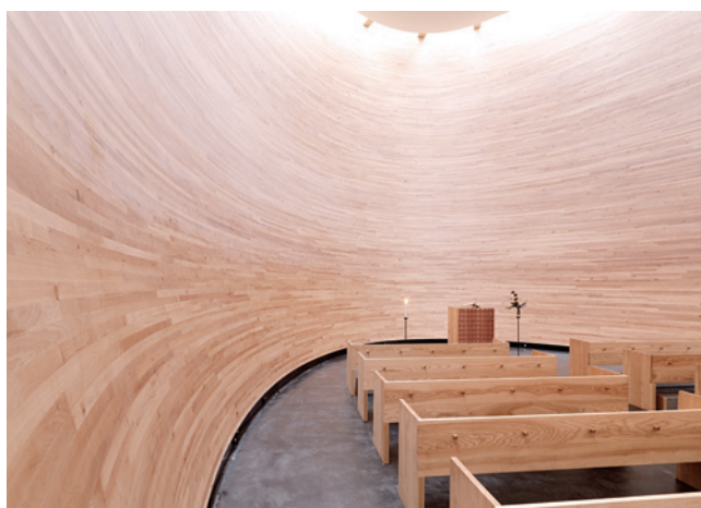
▲加工性を活かした例。積層時に曲面となるように切削。(カンピ礼拝堂／ヘルシンキ) 提供：Church in Helsinki / Evangelical Lutheran Church of Finland
