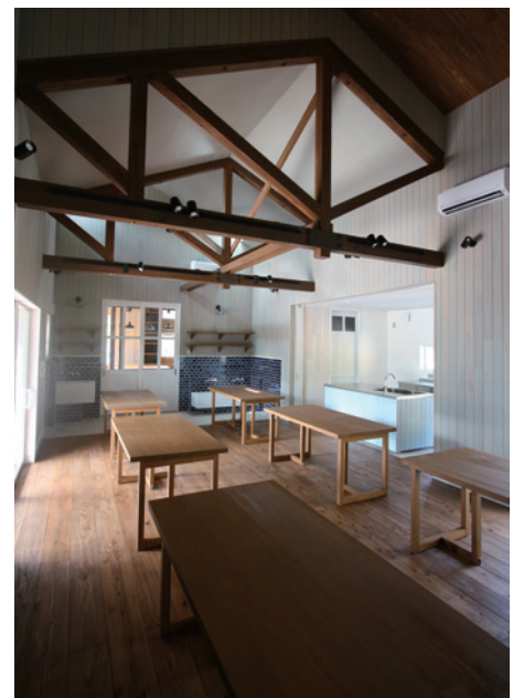
▲一般材によるトラス梁（シオンヴィレッジ/西之表市） 提供：DORON 建築設計事務所
