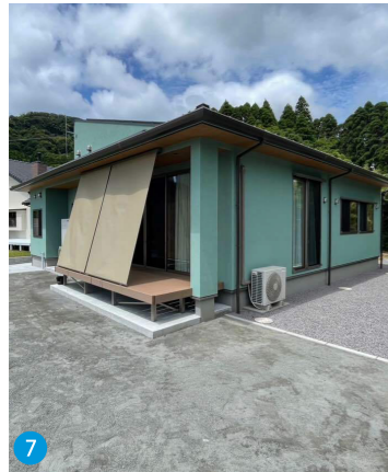
7 アウトリビングデッキはシェードを設け直射しを遮蔽。室内温度の上昇も抑えて心地よい室内に
