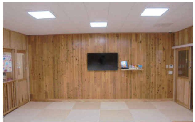
ほふく室 (正面壁は CLT 現し使用)
