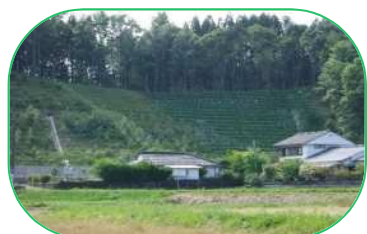
土砂崩れを防ぐ
