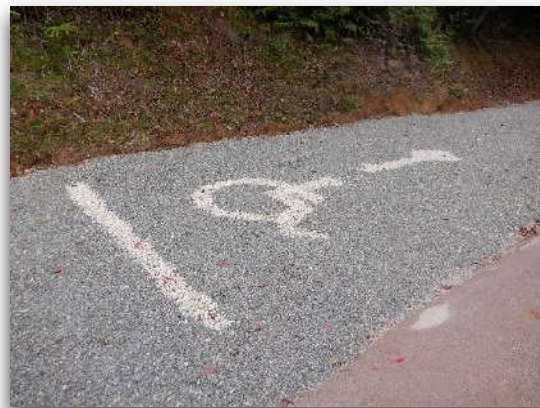
砂利道舗装と通路表示
