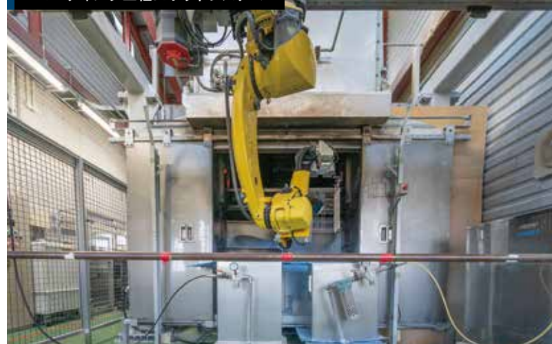
手作業からロボットアームによるものに。
