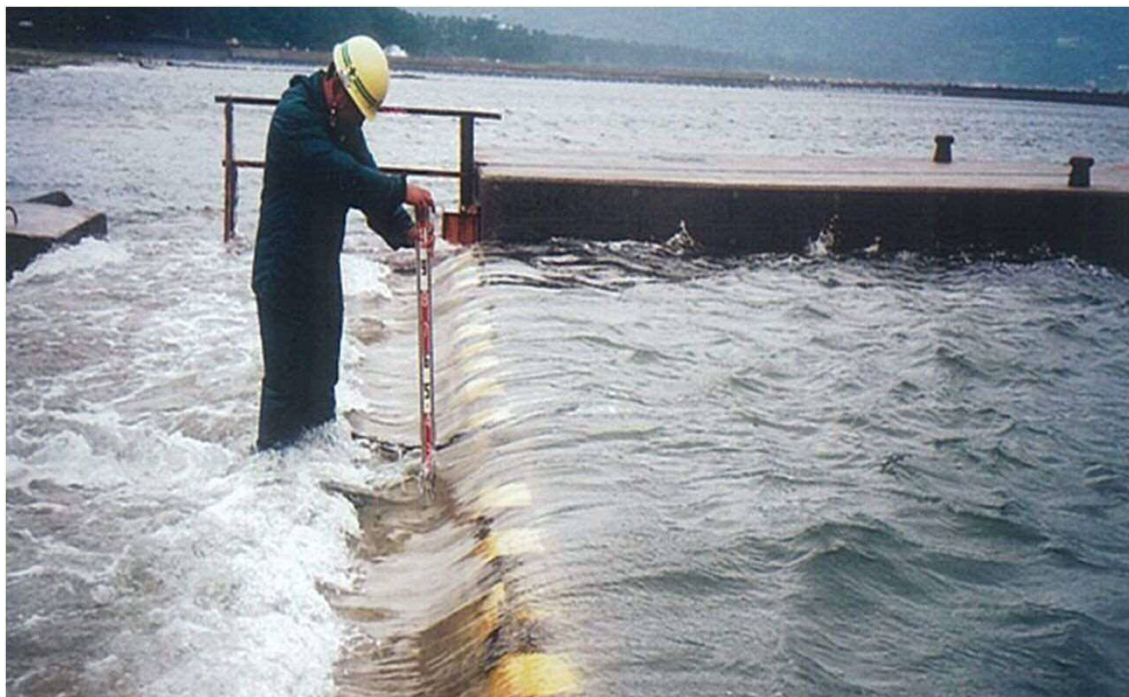
激浪時港内状況。静穏な水域が不足し、漁船の係留が困難となる。
