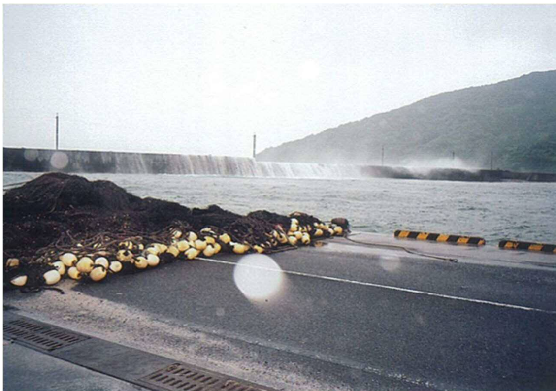
甲防波堤 越波状況。 県外船は基地港まで避難している状況であり、避難港としての役割を果たしていない。 平成17年9月撮影
