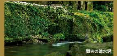
関吉の疎水溝
