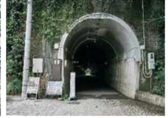
トンネルの入口
