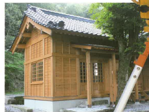
施工現場実習で手掛けた神社社務所
