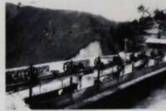
ヘッドタンク(水槽)
