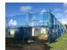
（防風ネットの設置）
