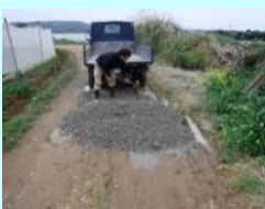
農道の路面補修
