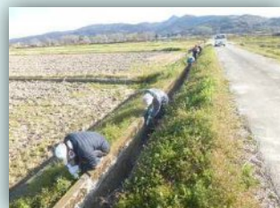
水路の目地詰め
