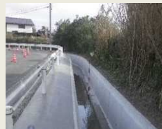
排水路の整備 (出水西部地区: 出水市)
