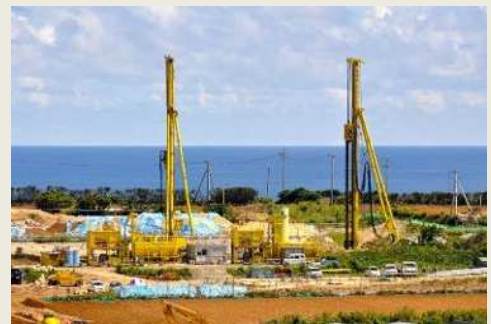
ダム軸施工状況(国営沖永良部地区：知名町)
