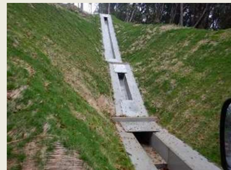
排水路の整備（麦生田地区：日置市）
