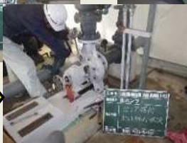
整備補修（オーバーホール）
