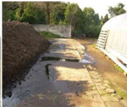
図2 堆肥の廃汁流出 （提供：富山県）
