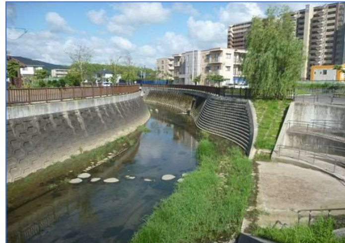
げすいどう せいびあと 下水道 整備後
