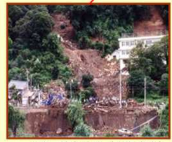
H5 花倉地区（鹿児島市） がけ崩れ災害 死者16名
