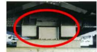
■対策完了により地震に強い橋へ
