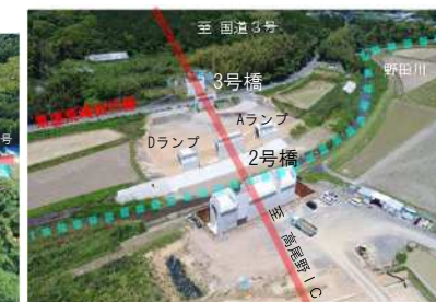
( (仮)野田南IC付近)
