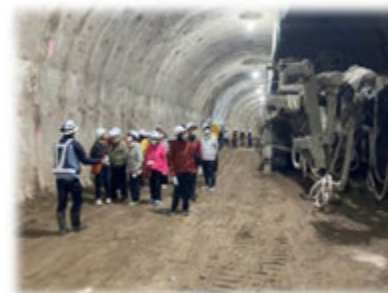
【 施工中のトンネルの現場を見学 】
