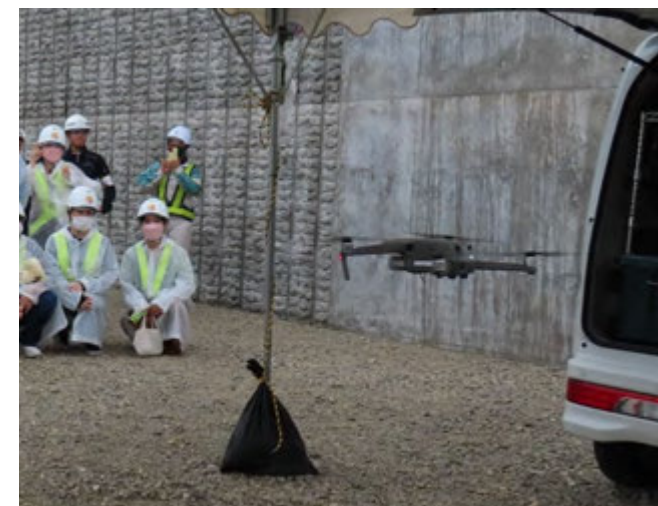
ドローンで写真撮影している様子
