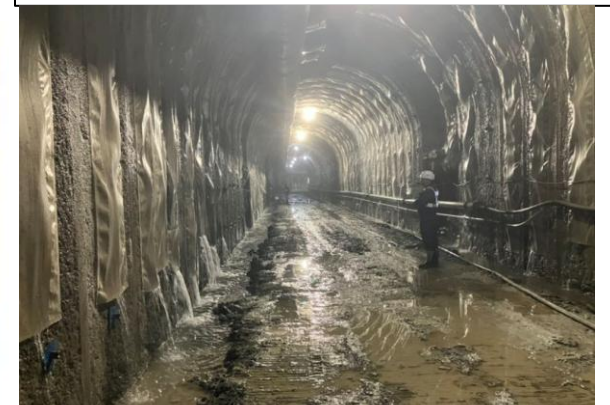
12/2撮影 水抜き導坑湧水状況
