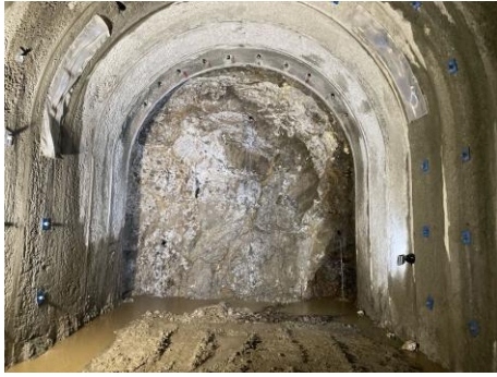
No. 7+5.95 被災箇所付近切羽状況 (147基)
