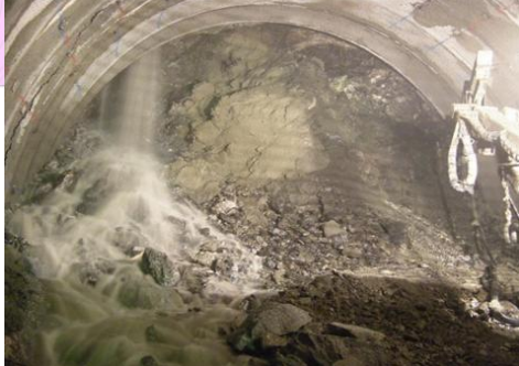
TD1807 大量出水時の切羽状況 5t/min（約300t/h）出水
