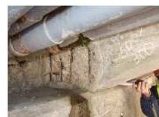
主桁損傷状況(橋梁)
