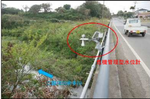
危機管理型水位計(余多川・天竜橋)
