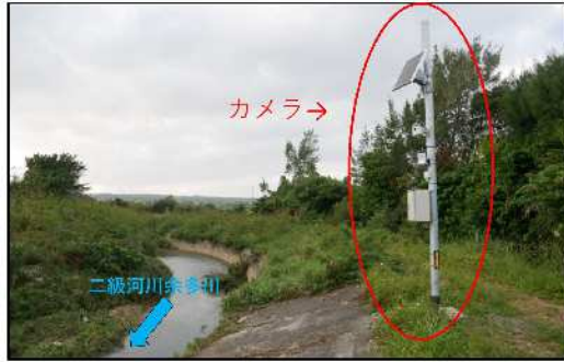
簡易型カメラ(余多川・天竜橋)
