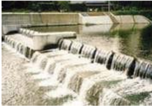
写真 4. 6. 2-3 鋼製起伏堰
