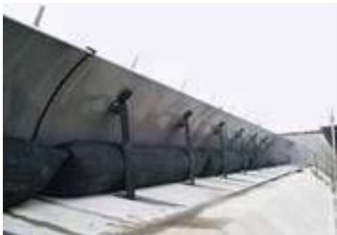
写真 4. 6. 2-5 S R合成起伏堰
