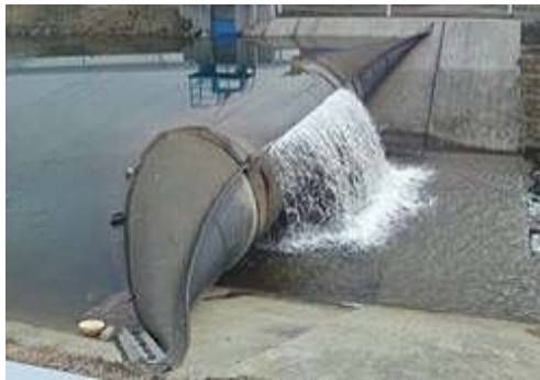
写真 4. 6. 2-4 ゴム引布製起伏堰
