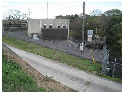
写真 2-5 吉元排水機場 (東串良町川西)
