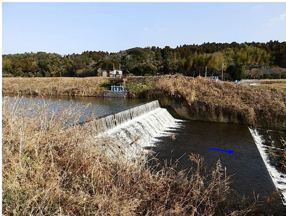
写真 2-6 取水堰を右岸から望む(大始良川)
