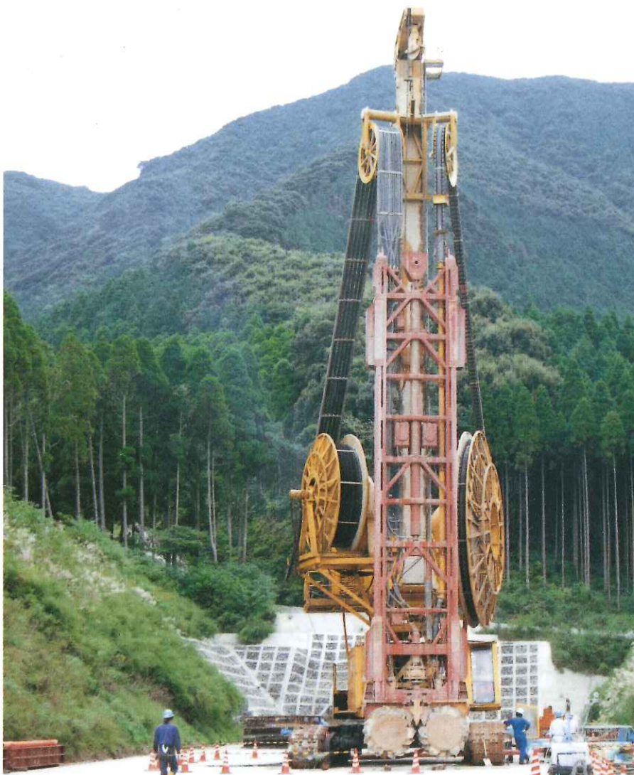
掘削機全景(回転式水平多軸工法)
