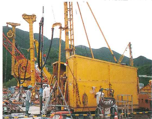
先行ボーリング掘削機
