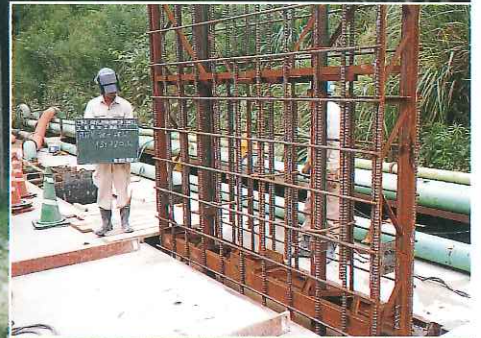
地中連続壁内部の鉄筋籠据付状況
