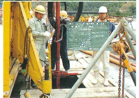
地中連続壁のコンクリート打設状況
