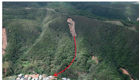
土石流(龍郷町加世間沢)9月25日発生 死者1名 住家全壊 1戸
