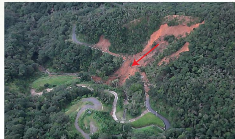
地すべり(瀬戸内町西阿室地区)11月2日発生
