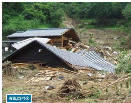
人家被災状況
