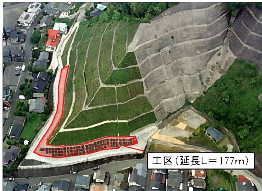
急傾斜地崩壊対策工事(田中宇都3地区)
