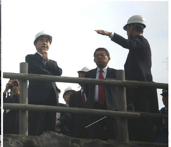
有村川砂防工事現場にて、大隅河川国道事務所長から説明を受ける平野達男防災担当大臣(鹿児島市桜島有村町)
