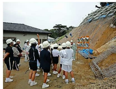
現場(急傾斜・山地区)見学会の様子
