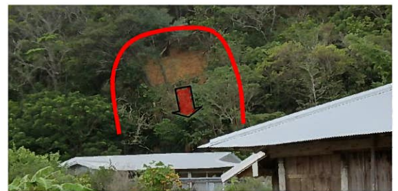
大島郡瀬戸内町三浦地区(がけ崩れ)
