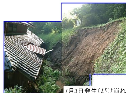
②【床浪地区】霧島市霧島川北地内
