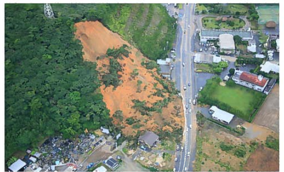
大島郡龍郷町浦6地区(地すべり)
