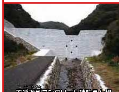
不透過型コンクリート砂防えん堤
