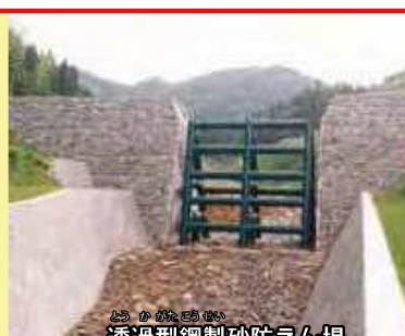
透過型鋼製砂防えん堤
