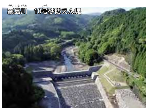
土砂や木々を受けとめた砂防えん堤
