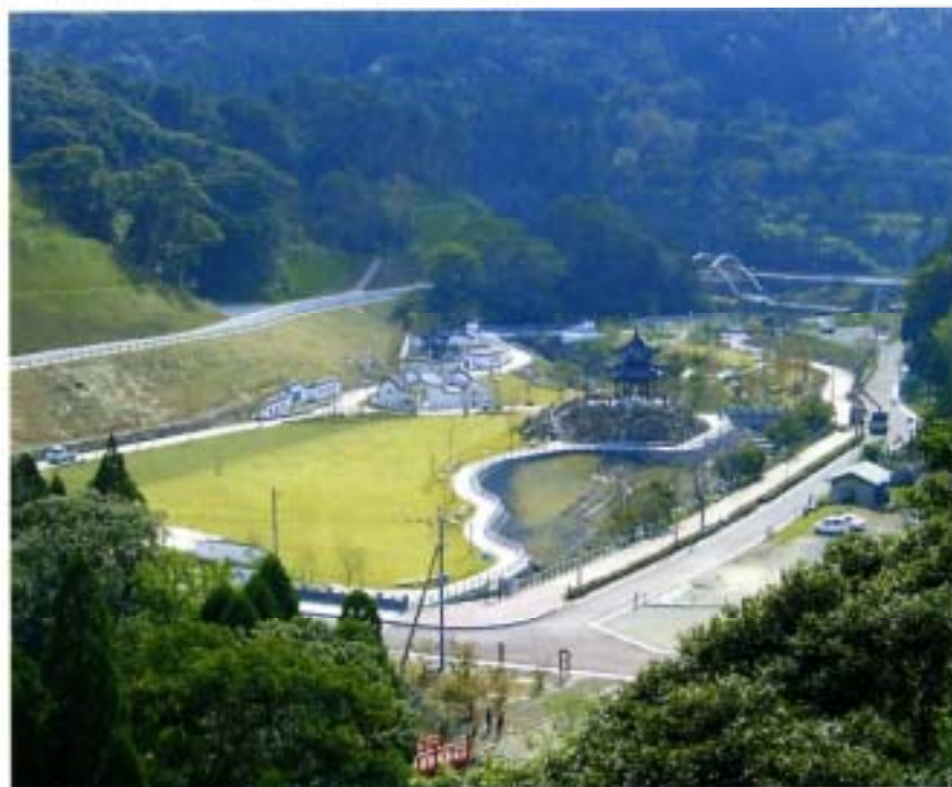
冠岳花川砂防公園全景
