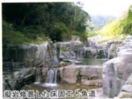
擬岩構築した砂防堰堤
