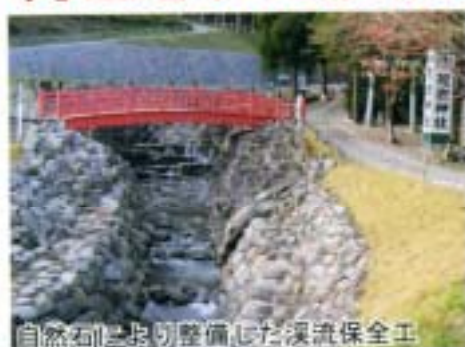
擬岩構築した床固工と魚道
