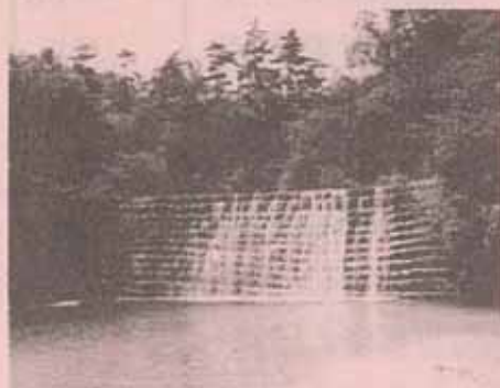
明治15年（1882年）に完成したオランダ式堰堤
